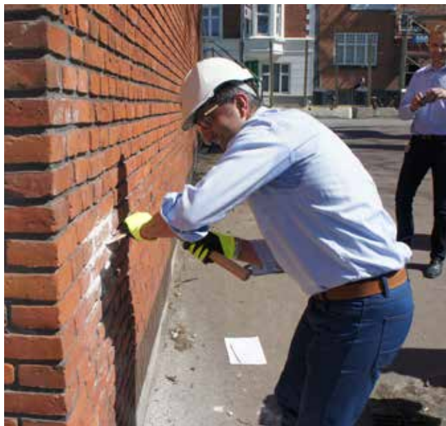
Børn og Unge Rådmand Bünyamin Simsek gravede den første mursten ud, der senere hen skal genbruges i det nye byggeri.
